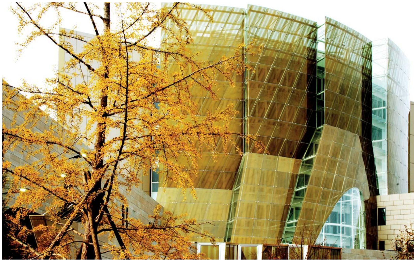
Au soubassement à bossage et parvis de granit, est opposée la façade sur le jardin, habillée d'un drapé plissé et ondulant de verre sérigraphié doré, qui lui donne tout son panache.
